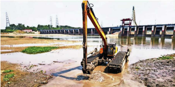
वजीराबाद बैराज के दोनो तरफ जितना पानी जमा था, उसे रिजर्वारियर तक लाने के लिए सोमवार को मास्टर वॉटर ड्रेजिंग मशीन से खुदाई की गई
