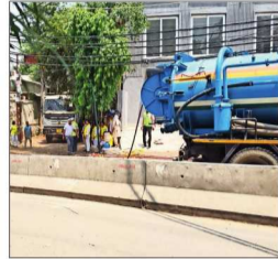
मलबा हटाने के दौरान उड़ती धूल को कम करने के लिए पानी का छिड़काव हो रहा
